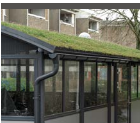
Bågformat tak med sedum
