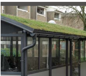
Bågformat tak med sedum
