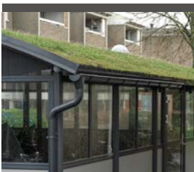
Bågformat tak med sedum
